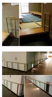
下待合室に補助手すりが設置 葬斎施設の地下通路部分と地
